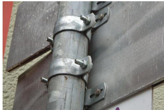
Abbildung 7-6 Pfeilwegweiser mit Stahlbandschellen befestigt
