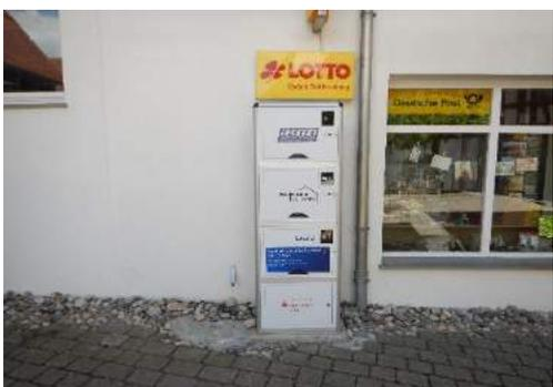
Abbildung 8: Ladestation für Pedelec-Akkus mit Schließfächern
