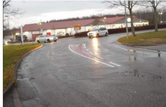
**Abbildung 5: Beispiel einer Aufstellfläche für linksabbiegenden Radverkehr**
